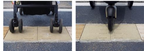
そこで、2 枚のブロックを背中合わせに並べて上のような平坦部の配置を再現できるようなブロックを考案しました。背中合わせになっている部分で、一般的な誘導ブロック 1 枚分の突起にほぼ相当します。中央にわずかなすき間があるために、三輪式ベビーカーや車輪間隔の狭いキャリーバッグもうまく通過できるようになっています。
