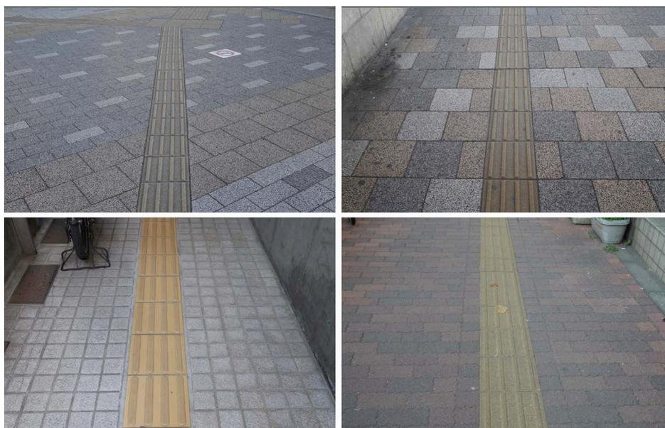
このような舗装では、どんな色あいの黄色を使っても、ブロックと周囲との輝度比や視認性を確保することは困難です。こうした場合でも十分な輝度比を確保するために、誘導ブロックの両側に暗い色の細長いタイル（インターロッキング）の帯を設置することが建築設計標準でも推奨されています。今回開発したブロックも、明るい色の舗装面では両側に暗い帯を設置するのを前提にしています。
